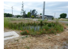
Bassin de phyto-épuration
